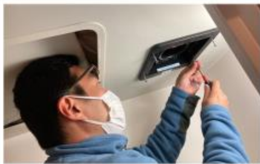
교회 게스트룸 환풍기 교체 작업
